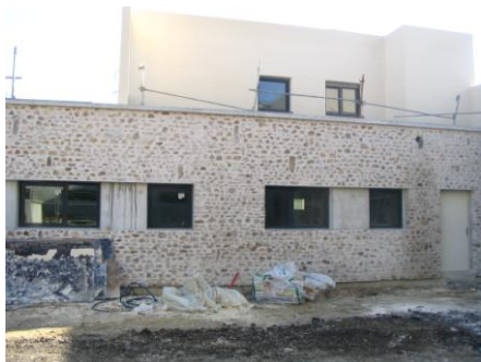
Les futurs bureaux administratifs
